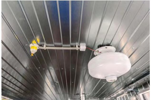
Модуль порошкового пожаротушения Тунгус
