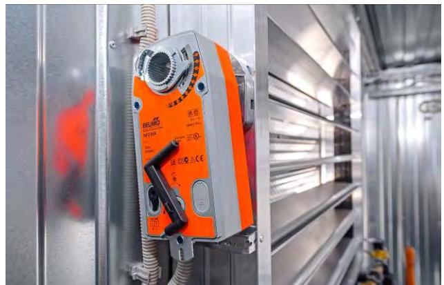
Внутри - автоматические клапаны притока-оттока воздуха с электроприводом Belimo 24/220 В
