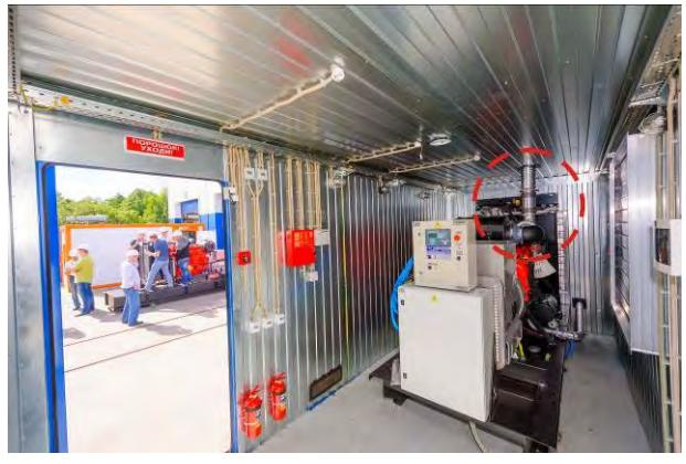
Тепло- и виброизолированная система газовых хлопов
