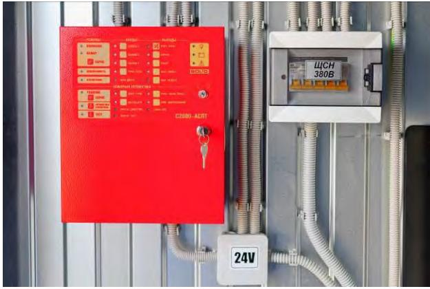
Система пожарной/охранной сигнализации на базе прибора C2000-АСПТ и щит собственных нужд контейнера (ЩСН)
